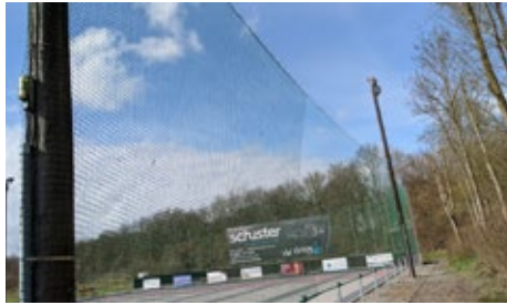
Verlängert wurde das Fangnetz neben der Spielbahn
