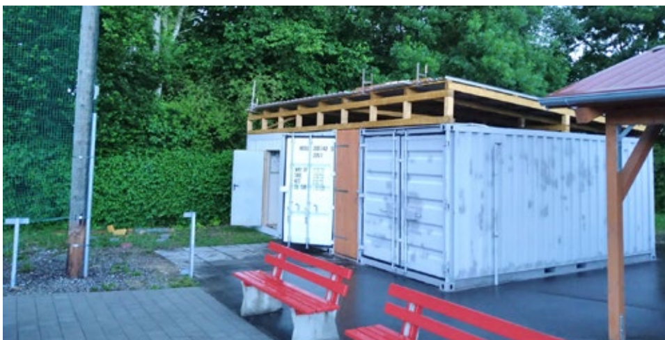
Mit der erweiterten und jetzt auch überdachten Lagerfläche haben sich die Stockschützen einen großen Wunsch erfüllt.
