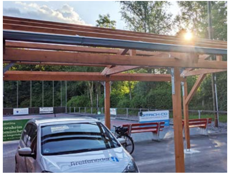
Der neue Anbau an der Hütte der Stockschützen wurde wieder in Eigenleistung erstellt.
